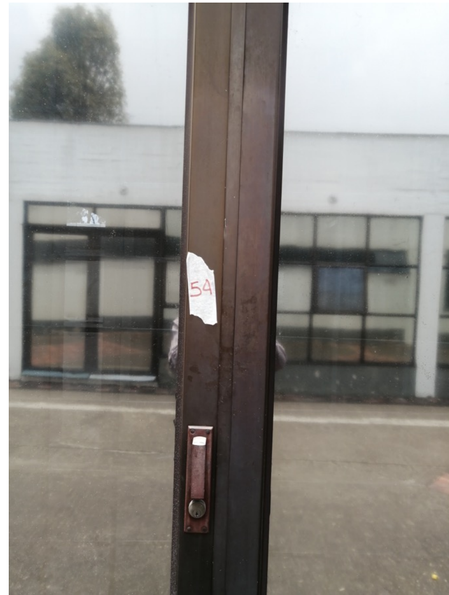
28. Puerta metálica en dos hojas en aluminio color similar a analoc con vidrio y reja de seguridad, apertura hacia el interior con medidas aproximadas de 1.50 x 2.20 metros
