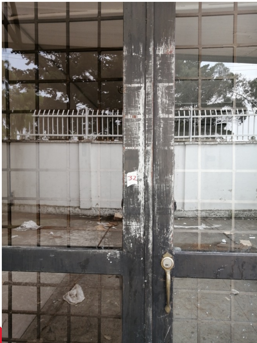
15. Puerta metálica en dos hojas en lámina cold rolled color negro con vidrio y reja metálica de seguridad, apertura hacia el interior con medidas aproximadas de 1.50 x 2.20 metros
