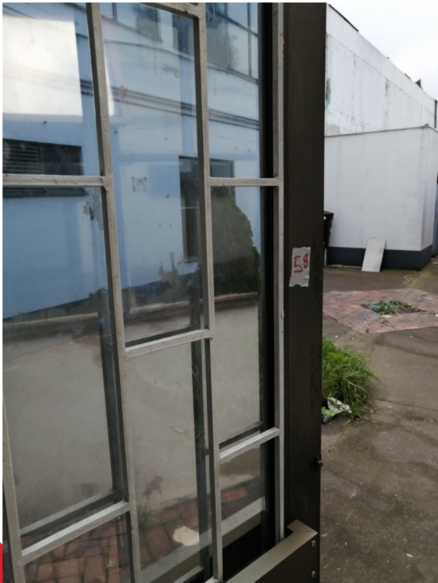
30. Puerta metálica en dos hojas en aluminio color similar a analoc con vidrio y reja de seguridad, apertura hacia el interior con medidas aproximadas de 1.50 x 2.20 metros
