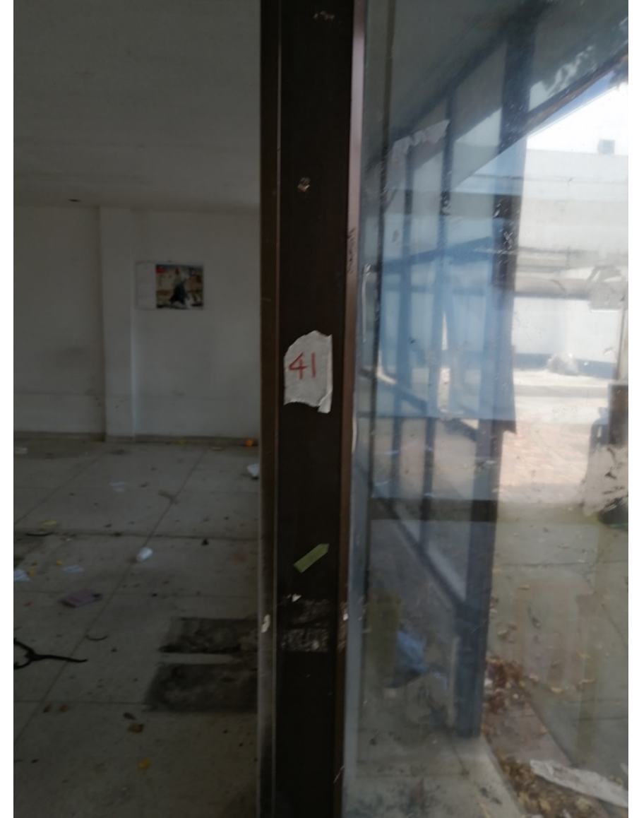
18. Puerta metálica en dos hojas en aluminio color similar a analoc con vidrio, apertura hacia el interior con medidas aproximadas de 1.50 x 2.20 metros
