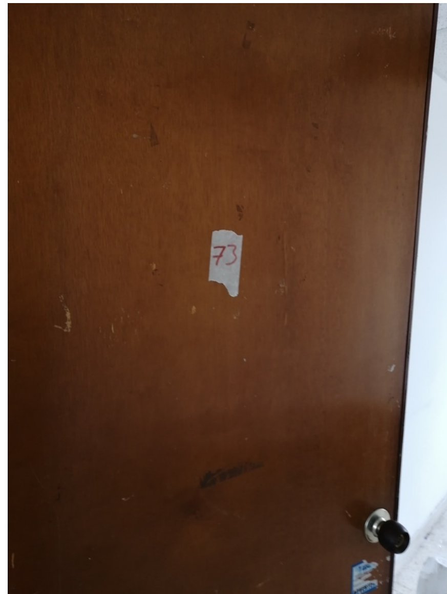
40. Puerta en madera de una hoja con acabado en triplex natural, apertura hacia al interior con medidas aproximadas de 0.80 x 2.10 metros.
