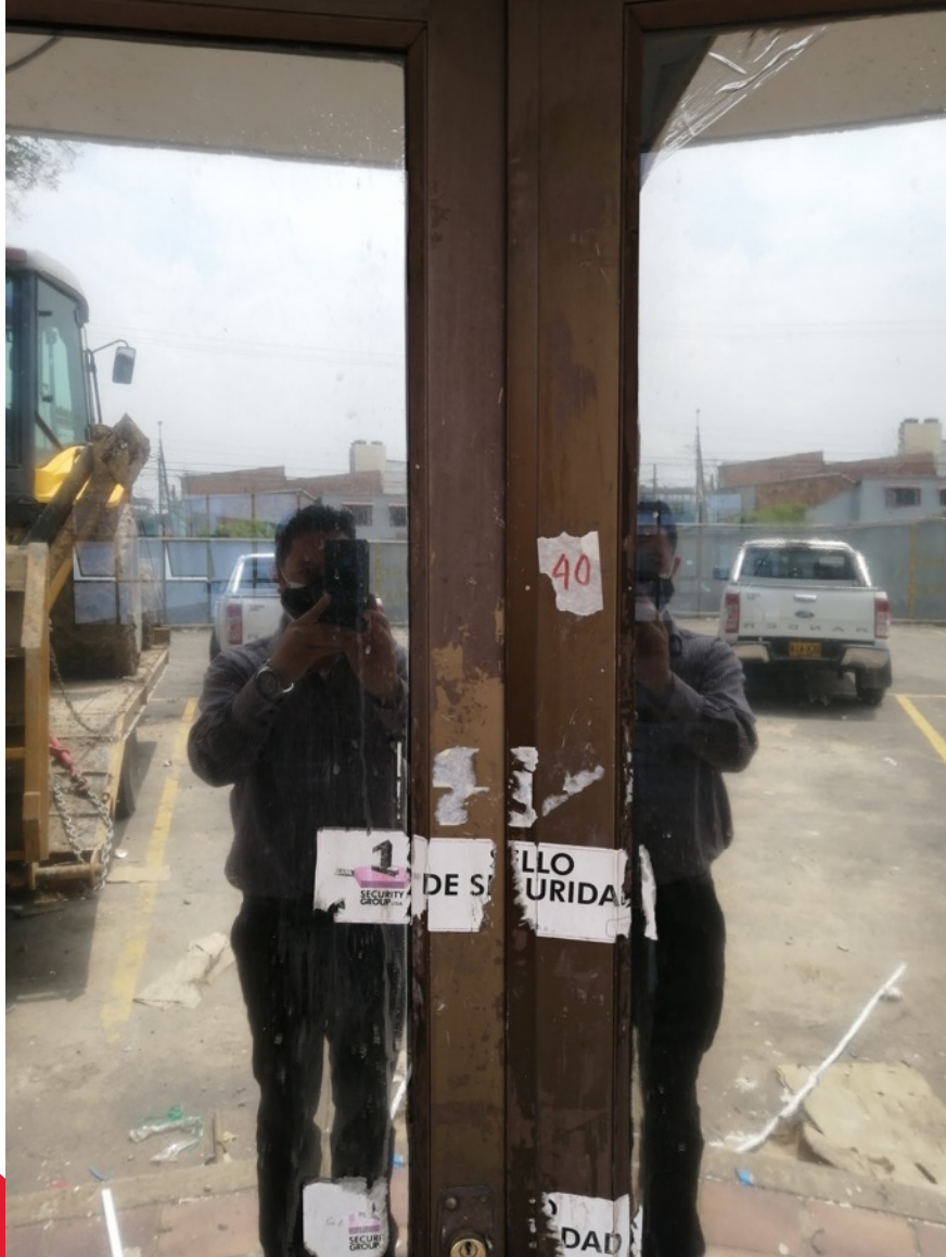
18. Puerta metálica en dos hojas en aluminio color similar a analoc con vidrio, apertura hacia el interior con medidas aproximadas de 1.50 x 2.20 metros
