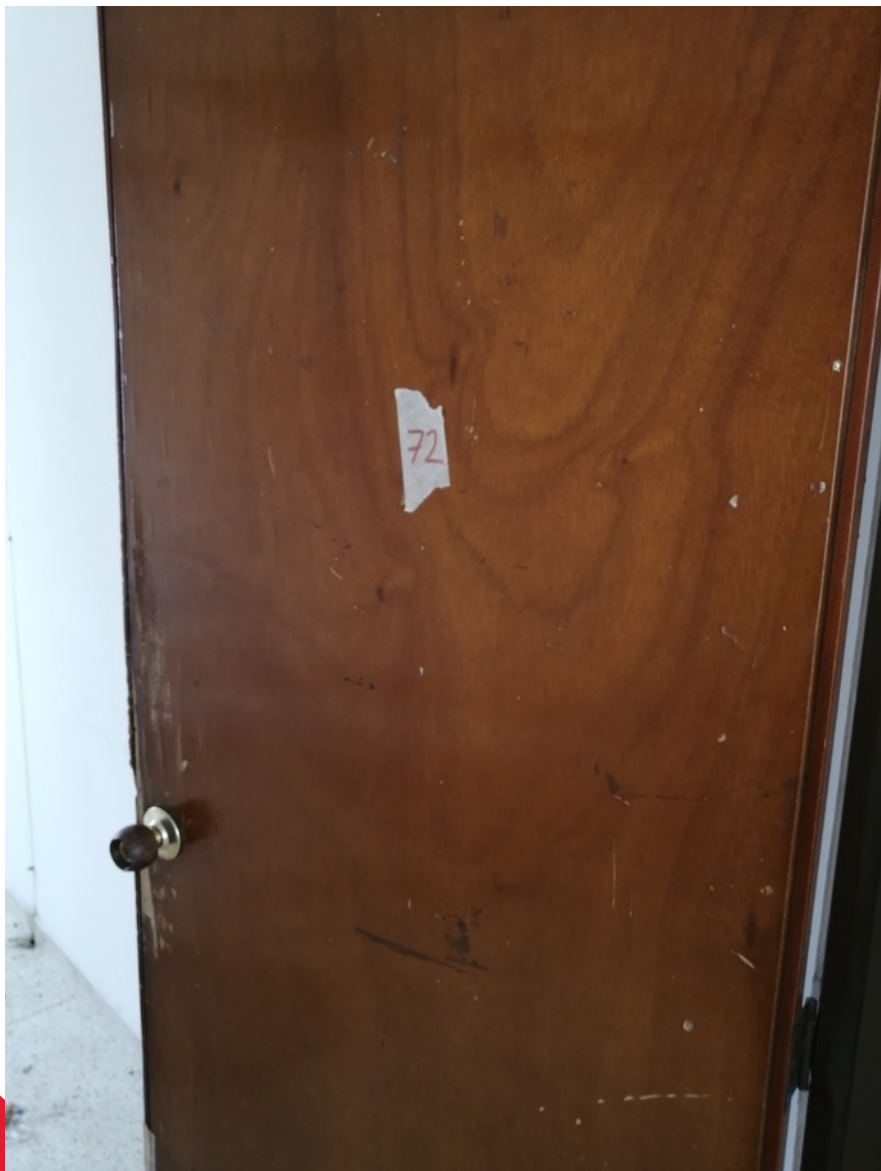
40. Puerta en madera de una hoja con acabado en triplex natural, apertura hacia al interior con medidas aproximadas de 0.80 x 2.10 metros.
