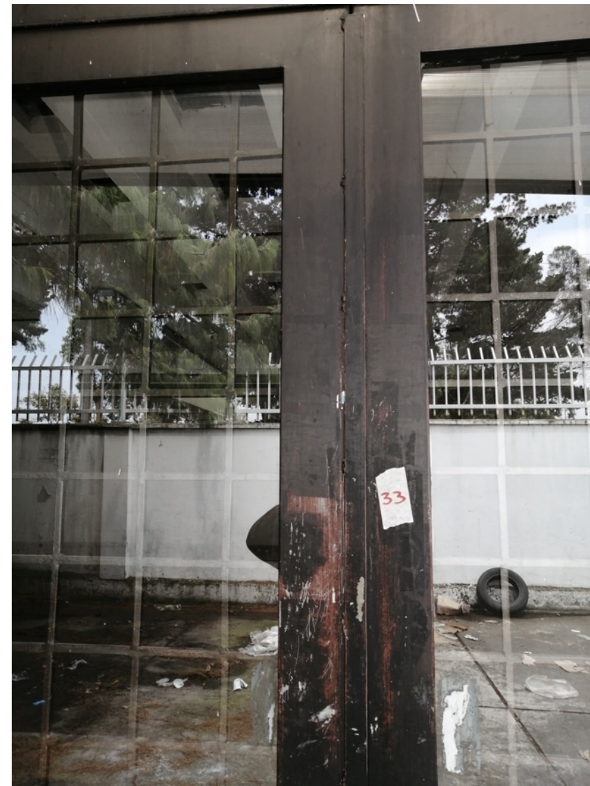
14. Puerta metálica en dos hojas en lámina cold rolled color negro con vidrio y reja metálica de seguridad, apertura hacia el interior con medidas aproximadas de 1.50 x 2.20 metros
