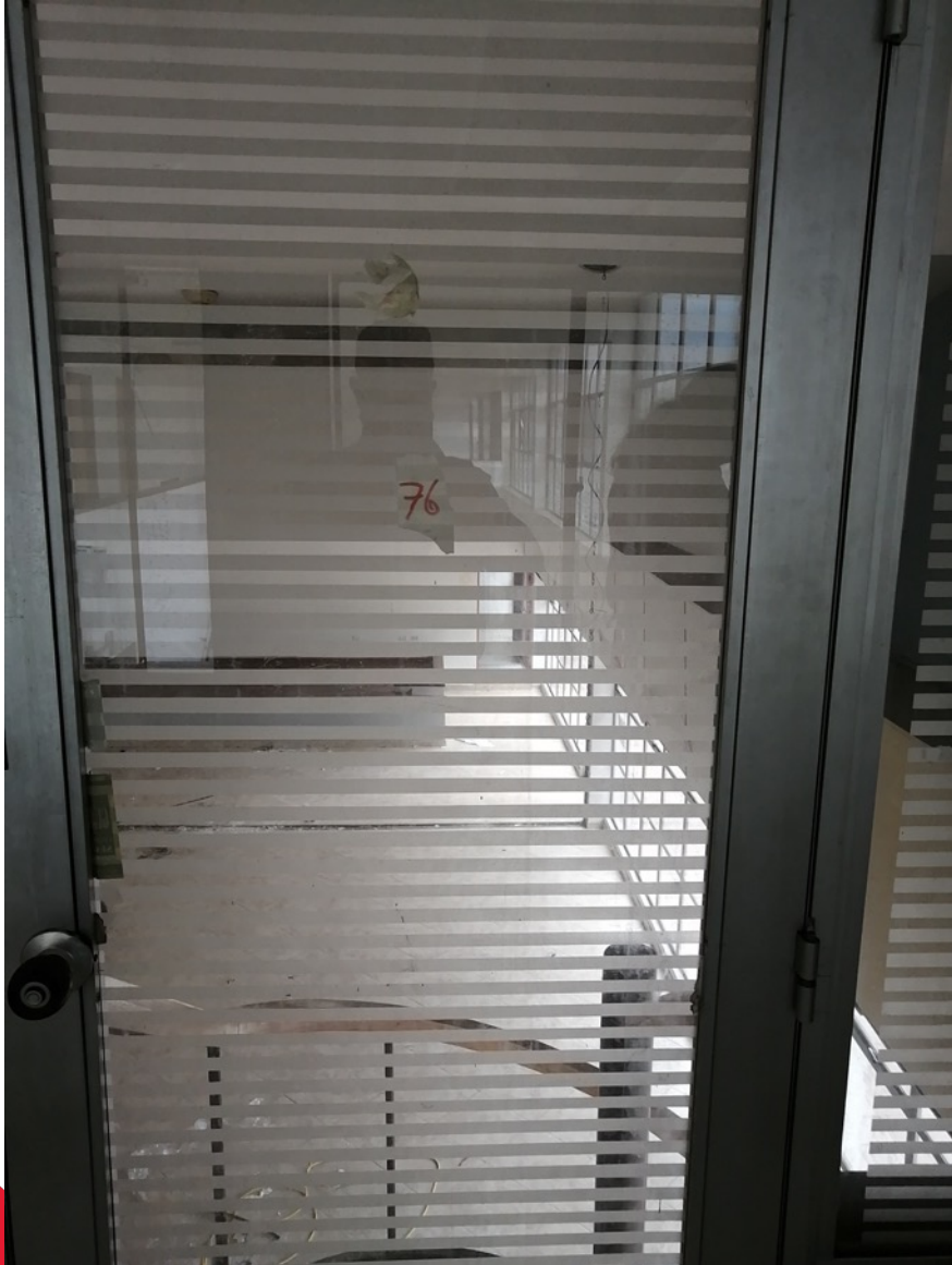
44. Puerta metálica de una hoja en aluminio color similar a analoc con vidrio, apertura hacia el interior con medidas aproximadas de 0.75 x 2.20 metros
