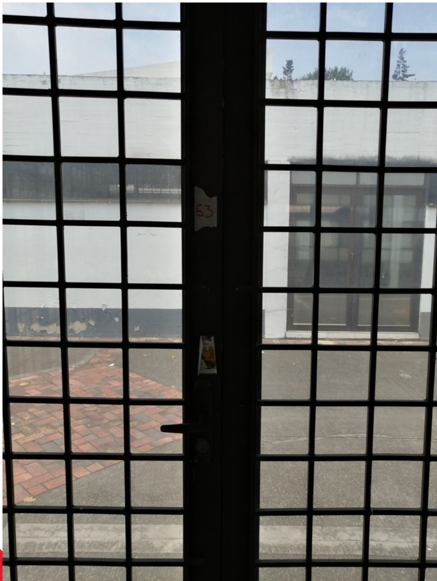
28. Puerta metálica en dos hojas en aluminio color similar a analoc con vidrio y reja de seguridad, apertura hacia el interior con medidas aproximadas de 1.50 x 2.20 metros
