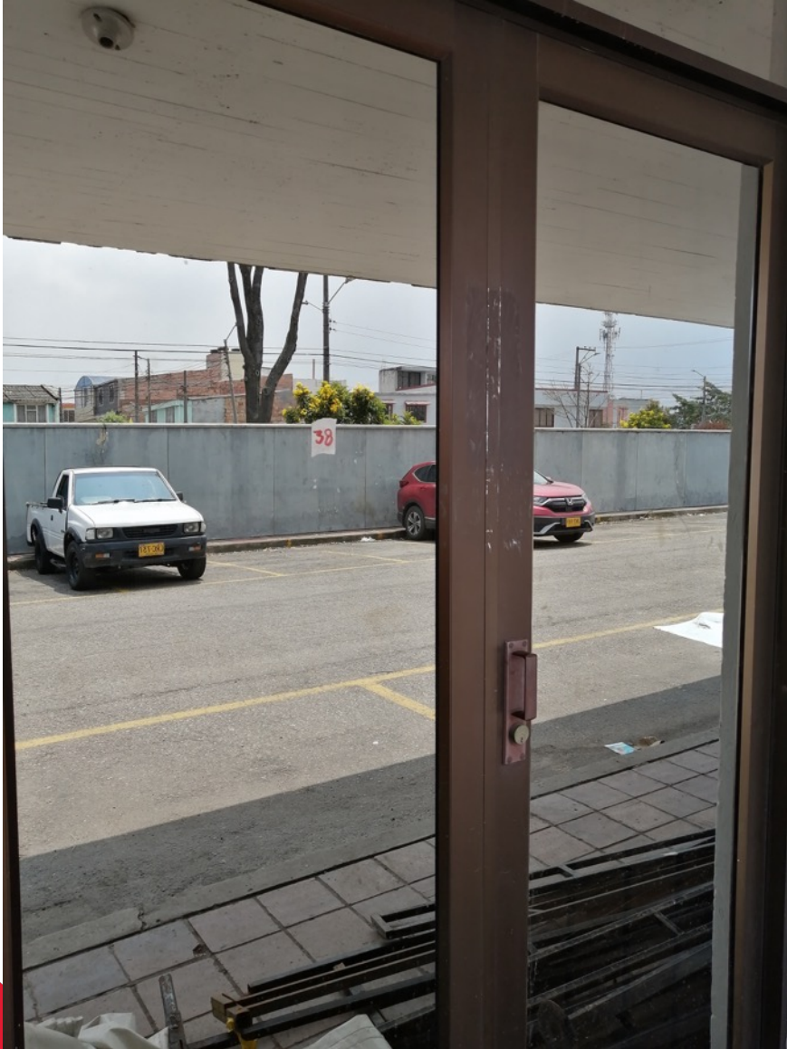
19. Puerta metálica en dos hojas en aluminio color similar a analoc con vidrio y reja metálica de seguridad, apertura hacia el interior con medidas aproximadas de 1.50 x 2.20 metros
