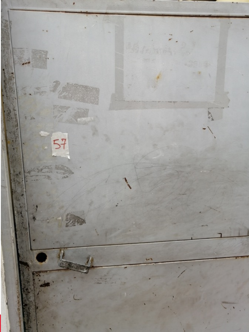
32. Puerta metálica de una hoja en lámina cold rolled con acabado en pintura blanca, apertura hacia el exterior con medidas aproximadas de 1.00 x 2.10 metros
