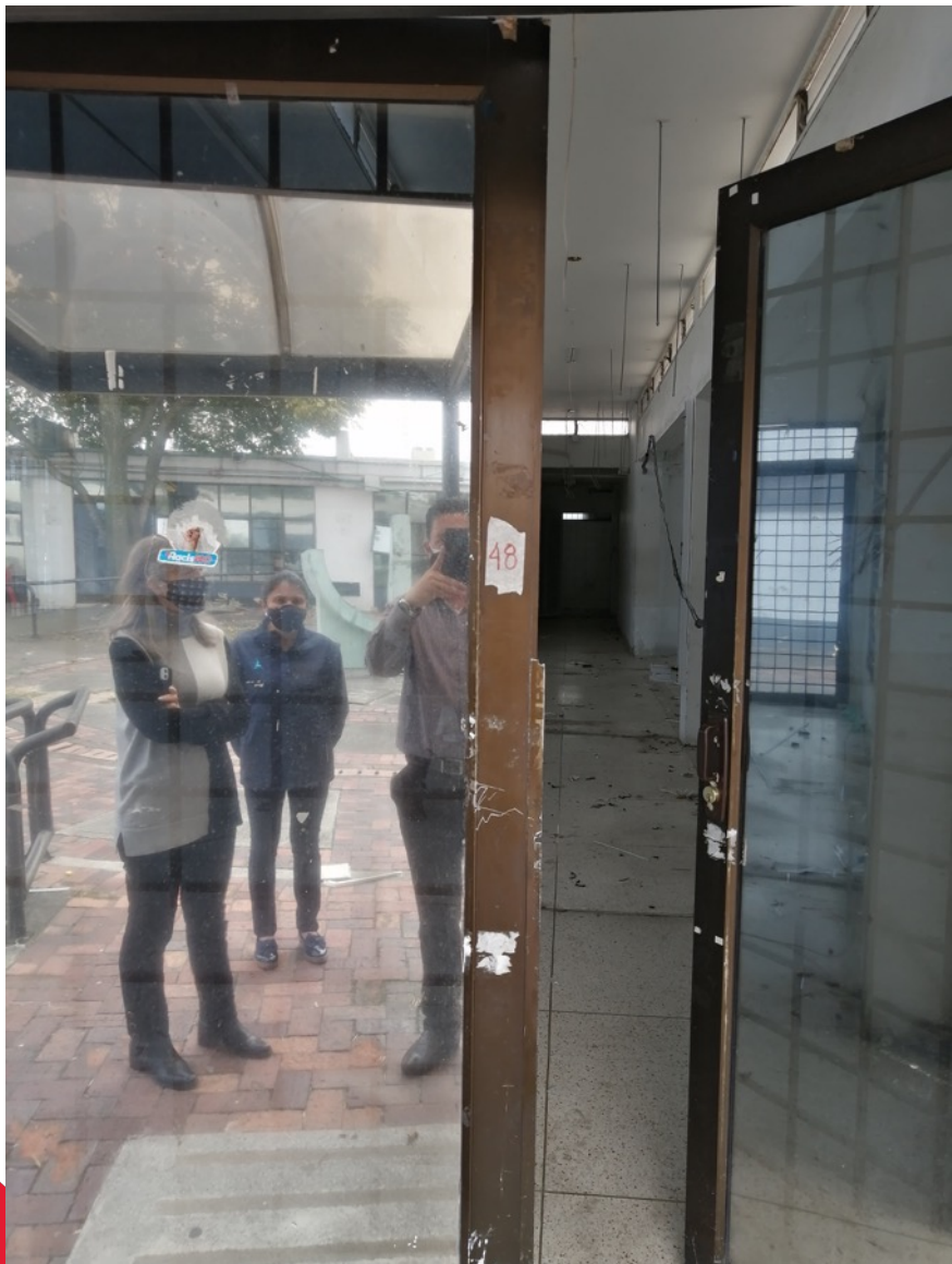
24. Puerta metálica en dos hojas en aluminio color similar a analoc con vidrio y reja de seguridad, apertura hacia el interior con medidas aproximadas de 1.50 x 2.20 metros
