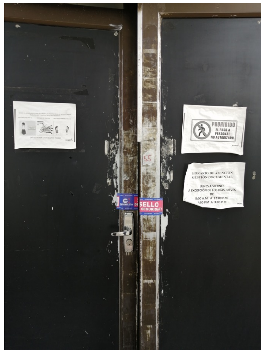
30. Puerta metálica en dos hojas en aluminio color similar a analoc con vidrio y reja de seguridad, apertura hacia el interior con medidas aproximadas de 1.50 x 2.20 metros
