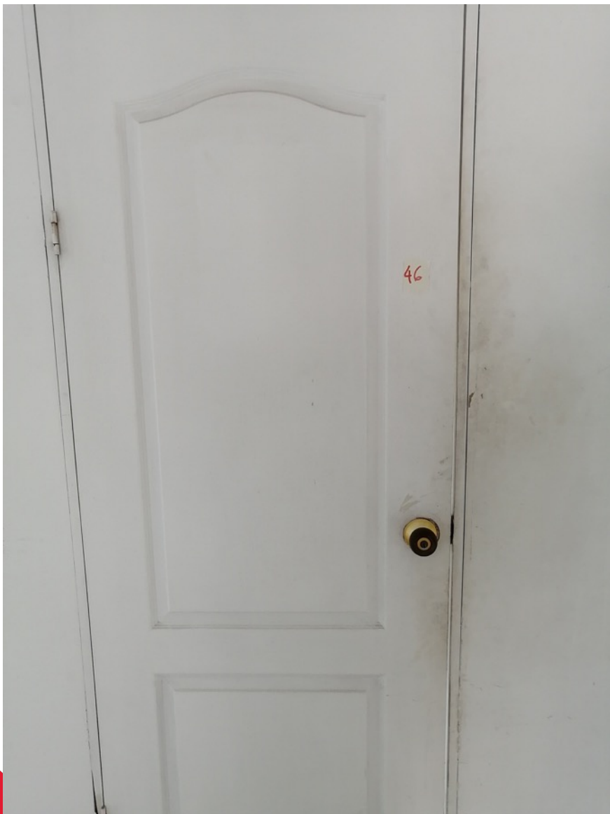
22. Puerta en madera de una hoja con acabado en pintura blanca, apertura hacia al interior con medidas aproximadas de 0.60 x 2.10 metros.
