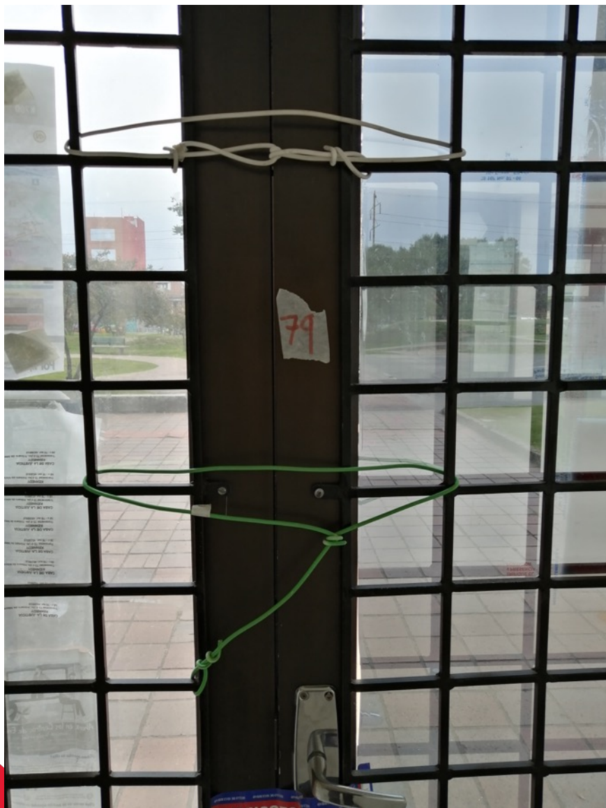
46. Puerta metálica en dos hojas en aluminio color similar a analoc con vidrio y reja de seguridad, apertura hacia el interior con medidas aproximadas de 1.50 x 2.20 metros
