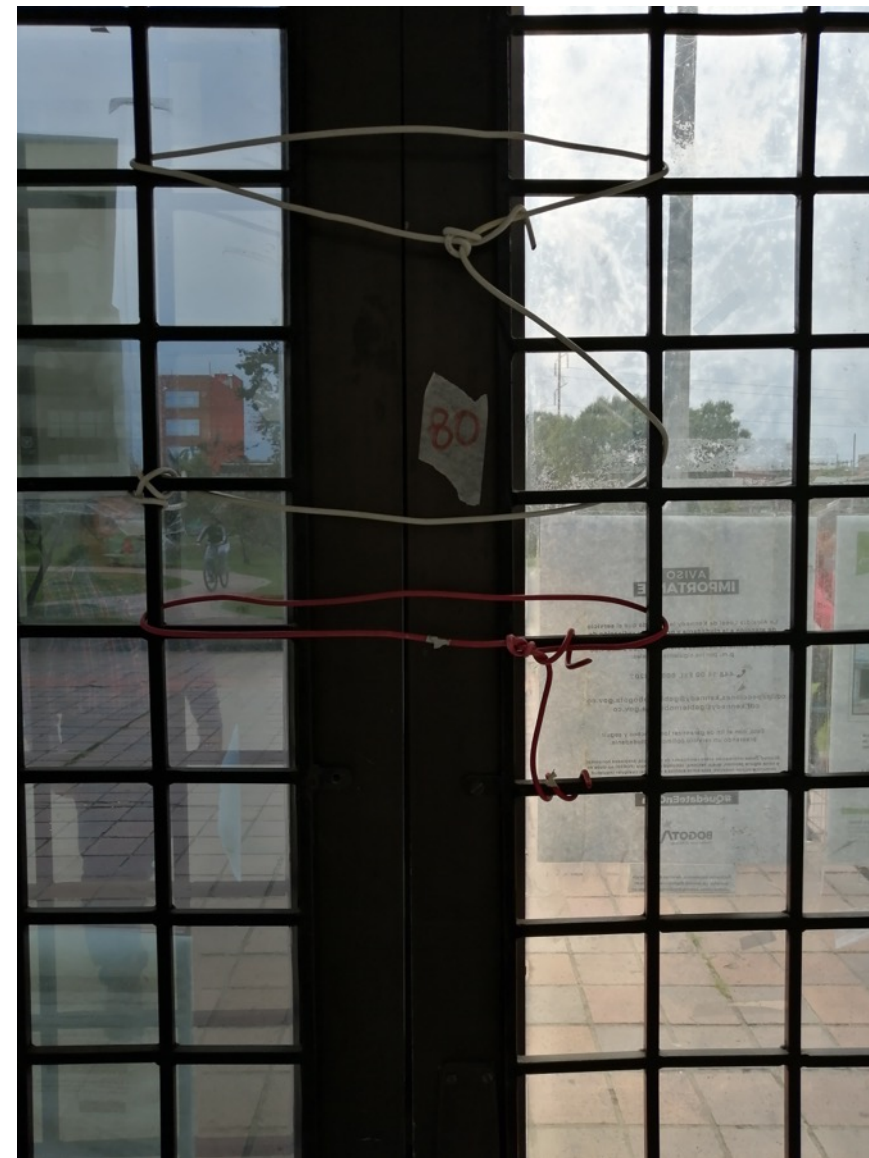
46. Puerta metálica en dos hojas en aluminio color similar a analoc con vidrio y reja de seguridad, apertura hacia el interior con medidas aproximadas de 1.50 x 2.20 metros
